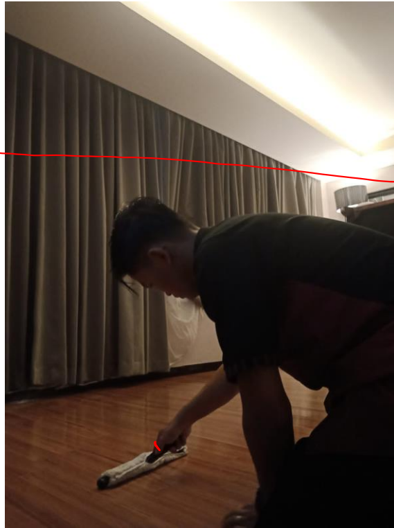
Gambar 6. Proses coating parquet (sumber : dokumentasi penulis)
