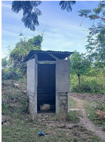
Gambar 4.5. Toilet Pantai Penyisok
